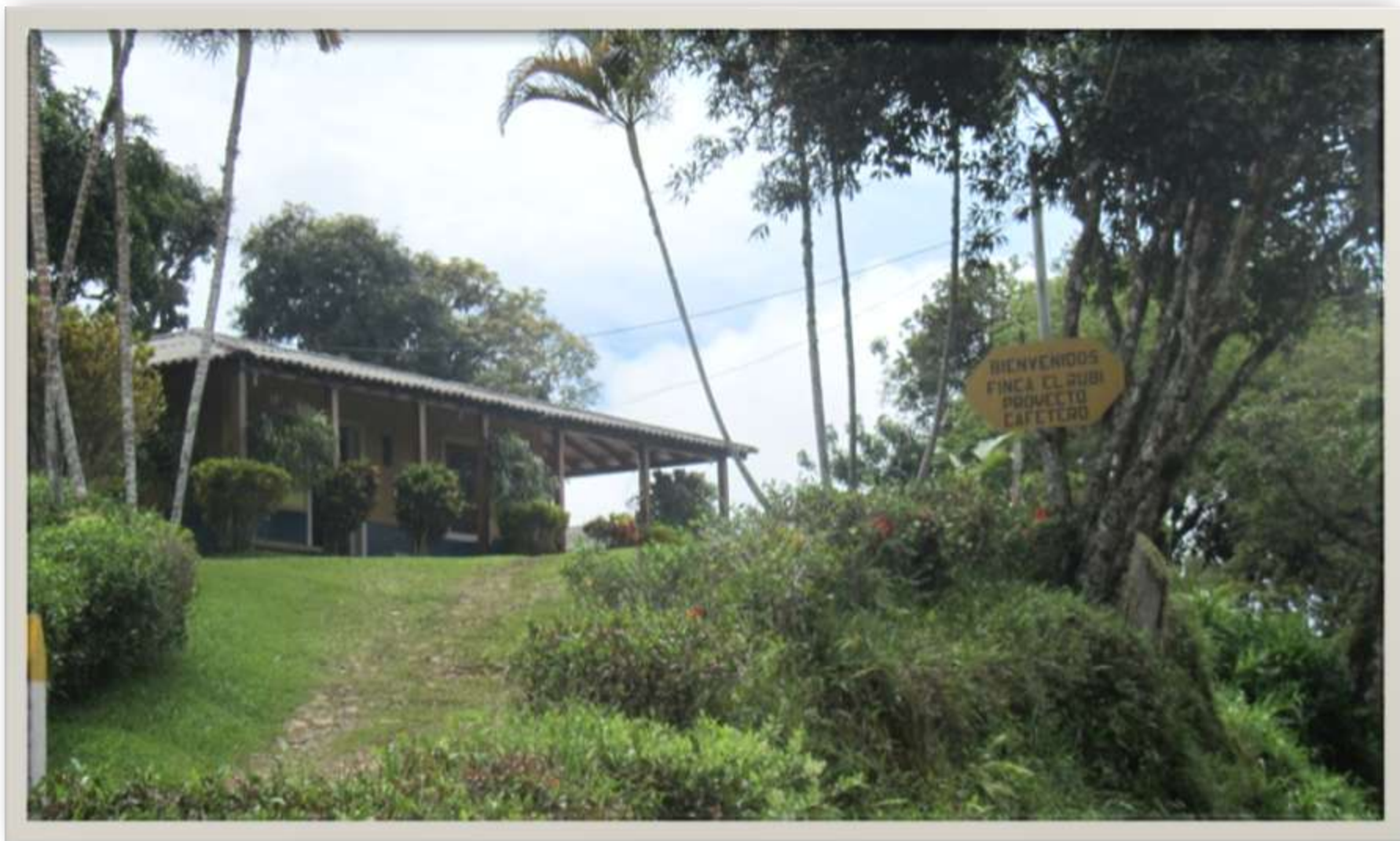
VISITA DE FINCA CAFETERA CON INSTALACIONES DE LAVADO Y SECADO DE CAFÉ ORGANICO.
