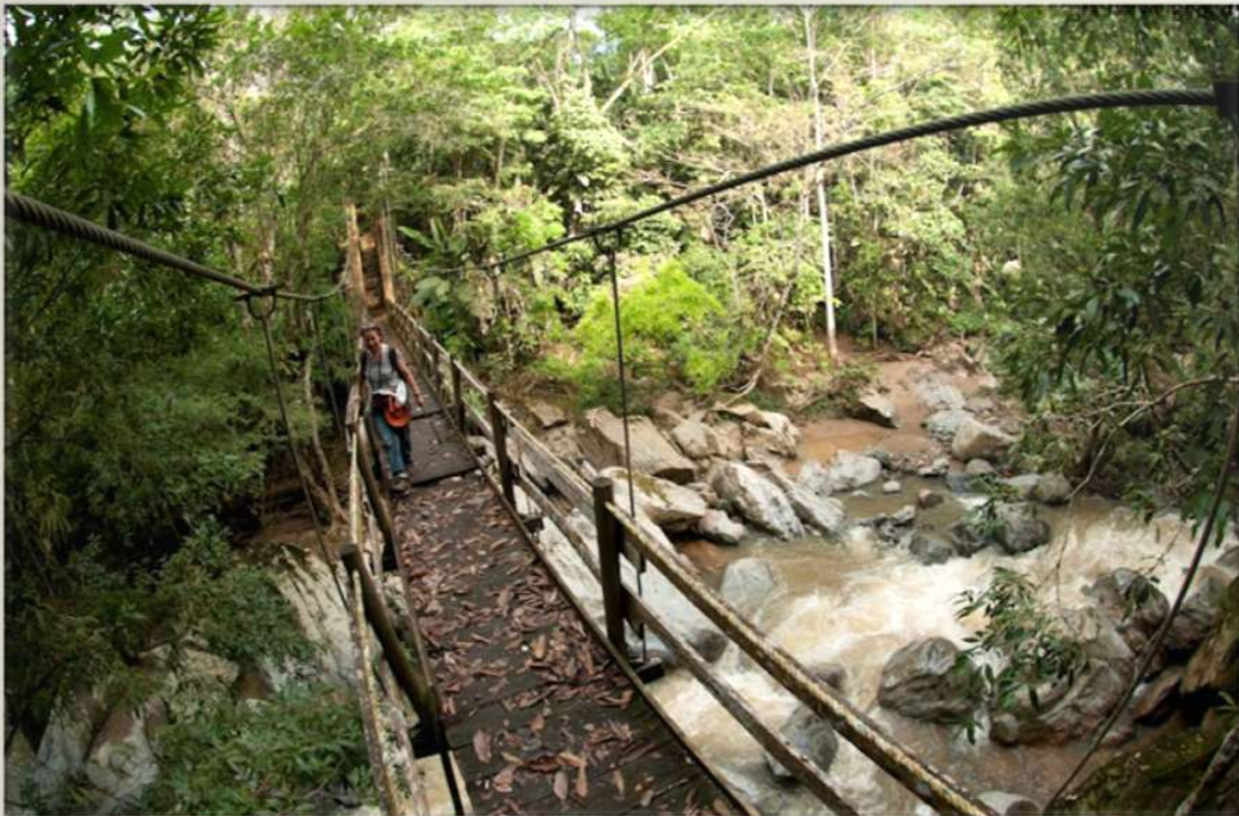
PUENTE COLGANTE EN QUEBRADA GUARDA SOL
